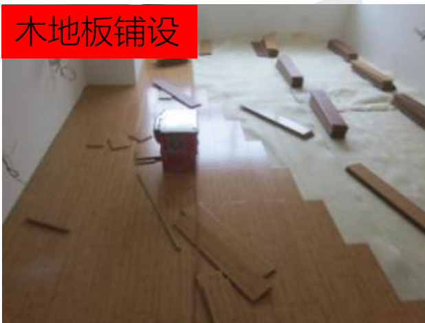
西卡胶/雷施地板胶弹性粘结系统
