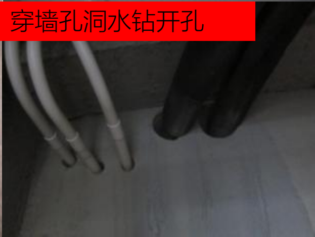
穿墙孔洞水钻开孔
